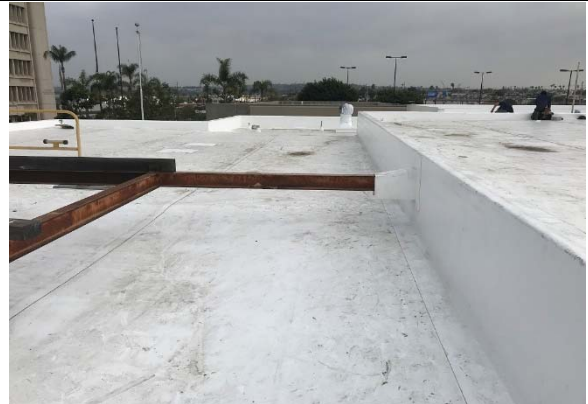
Inglewood Juvenile Center - Inglewood - Roof
