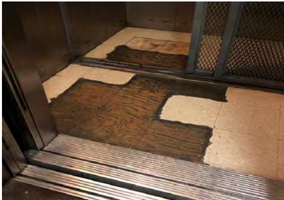
Van Nuys West Courthouse - LA - Elevator
